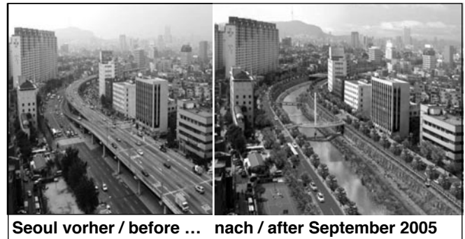
Abb. 1: Vorbildlich intelligent hat der Bürgermeister von Seoul, heute Präsident der Republik Südkorea, die Verkehrsinfrastruktur angesichts Peak Oil verändert: er ließ die 40 Jahre alte Autobahn nicht wie vorgesehen erneuern, sondern abreißen, legte den Fluss frei, schuf eine Grünzone, wo früher Beton war. Und die Stadt begann wieder zu leben, nicht nur die Menschen kamen in die Stadt, die Geschäfte blühten auf. Auch die Tierwelt fand die neue Infrastruktur so attraktiv, dass sich die Zahl der Fisch- und der Vogelarten in wenigen Jahren vervielfachte, weil auch das Klima durch die lebendige Oberfläche wieder attraktiv wurde.
