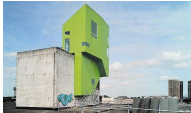
Abb. 2: Der Parasit von „Las Palmas“: Dieses kleine unkonventionelle Wohngebäude auf dem Liftschacht eines ehemaligen Lagerhauses im Rotterdamer Hafengelände Kop van Zuid wurde von den holländischen Architekten Rien Korteknie und Mechthold Schumacher im Rahmen des Programms Europäische Kulturstädte 2001 entworfen und in Massivholz ausgeführt. – Foto: Korteknie & Stuhlmacher.
