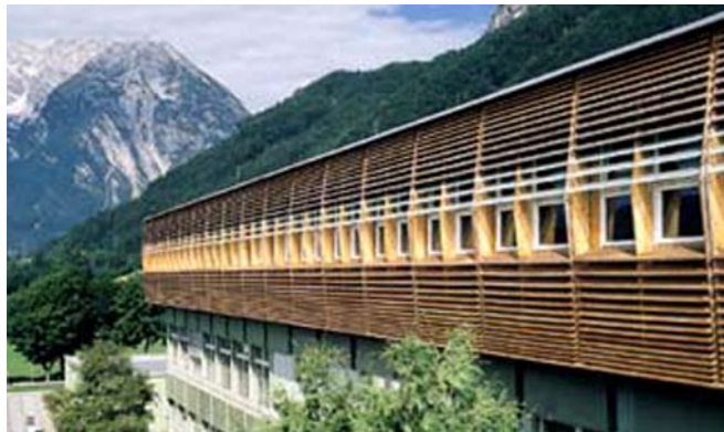
Abb. 1: Zubau des Bundesrealgymnasiums Stainach des Architekten Alfred Bramberger. Der Dachaufbau wurde infolge der altersbedingten Festigkeitszunahme des unterliegenden tragenden Betonbaus ermöglicht. Die Laststeigerung durch die Aufstockung am bestehenden Altbau von 8–9 Prozent konnte dank der höheren Belastbarkeit des Betons von rund 20 Prozent problemlos abgedeckt werden. – Foto: Paul Ott.
