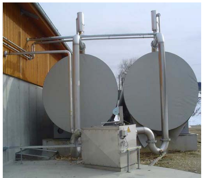
Abb. 1: Eine Biogasanlage in Oberösterreich.
