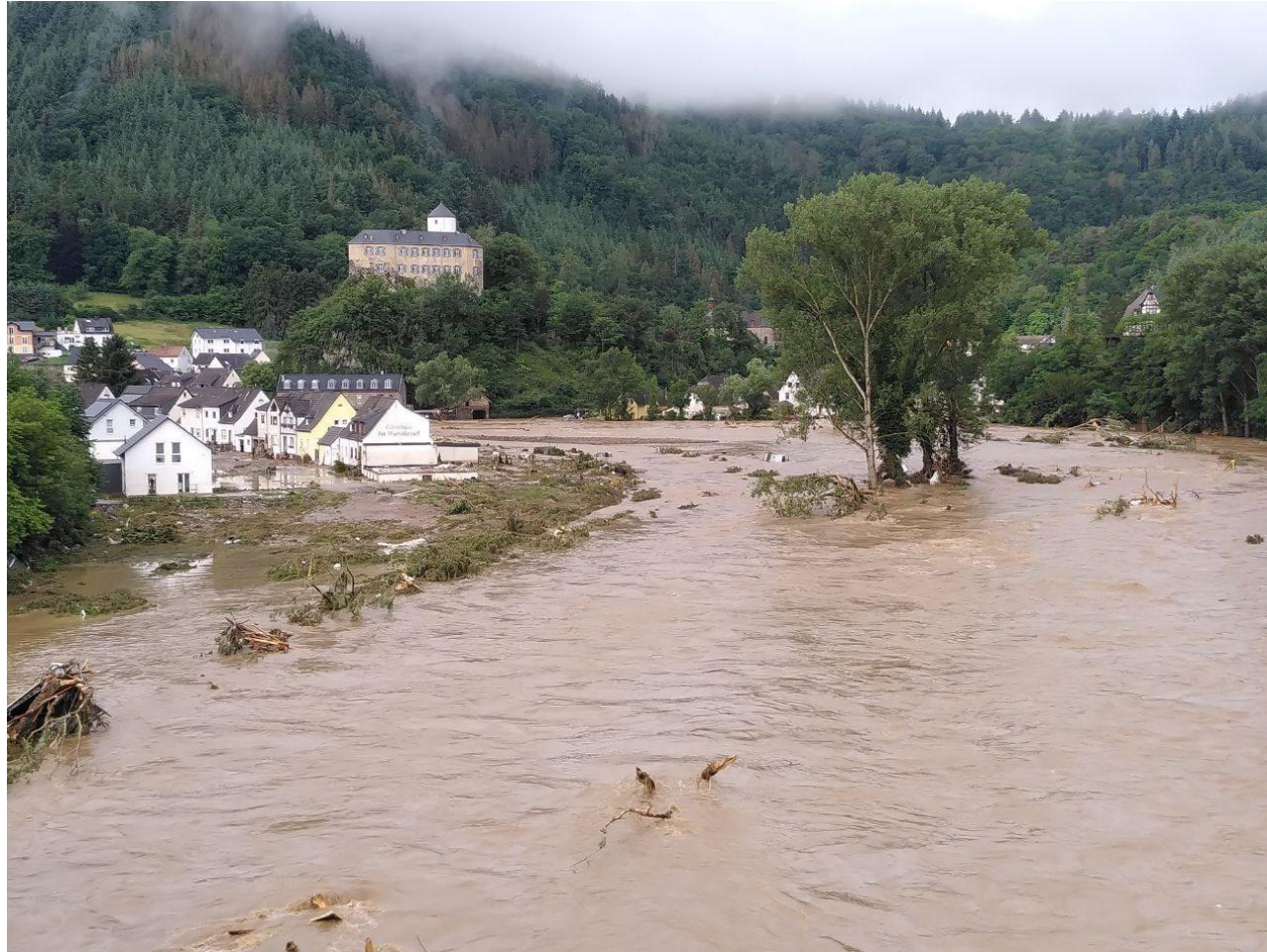
Hochwasser in Altenahr-Kreuzberg am 15. Juli 2021
